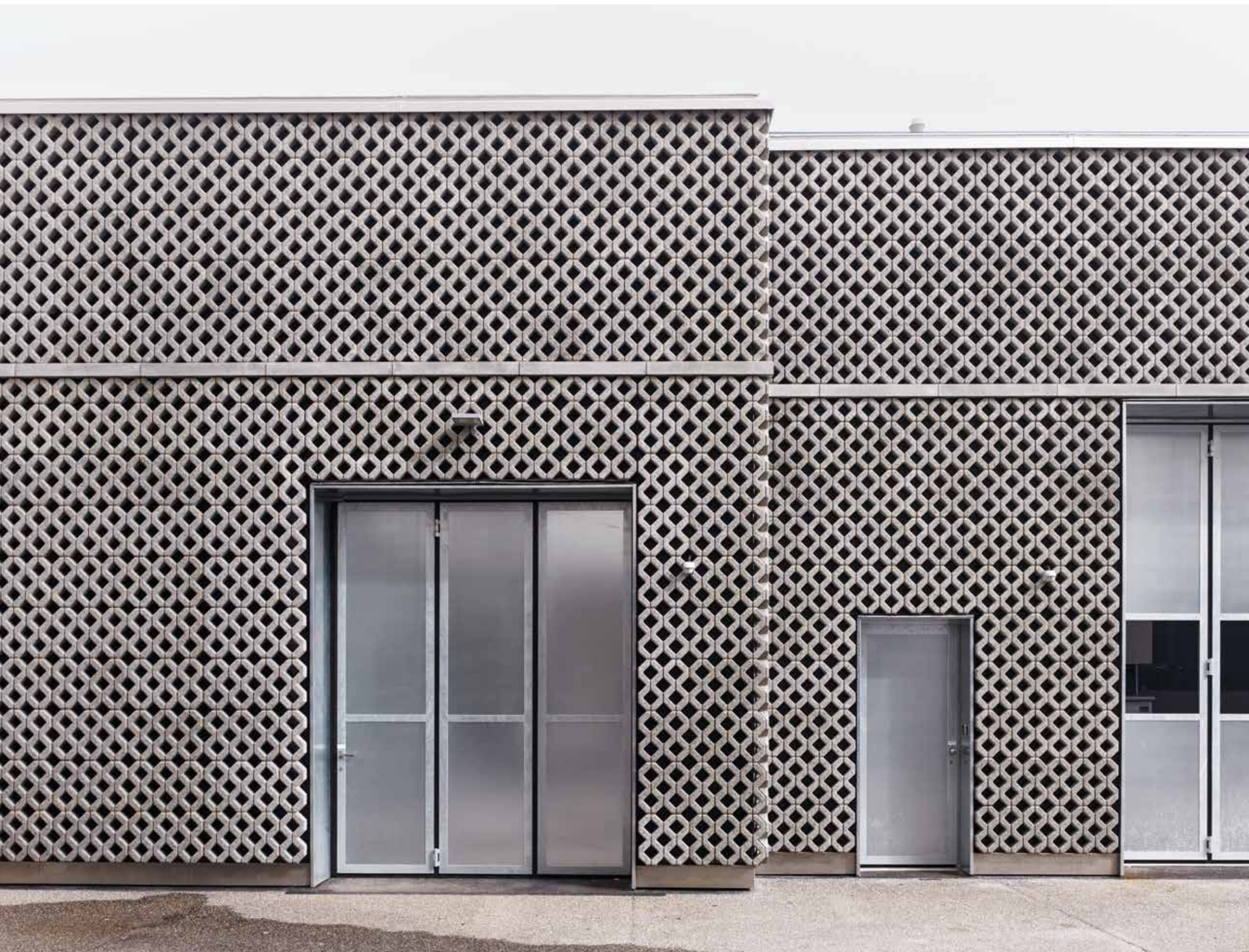
Sanierung Werkhof ERZ, Kehlhof, Zürich-Wiedikon
