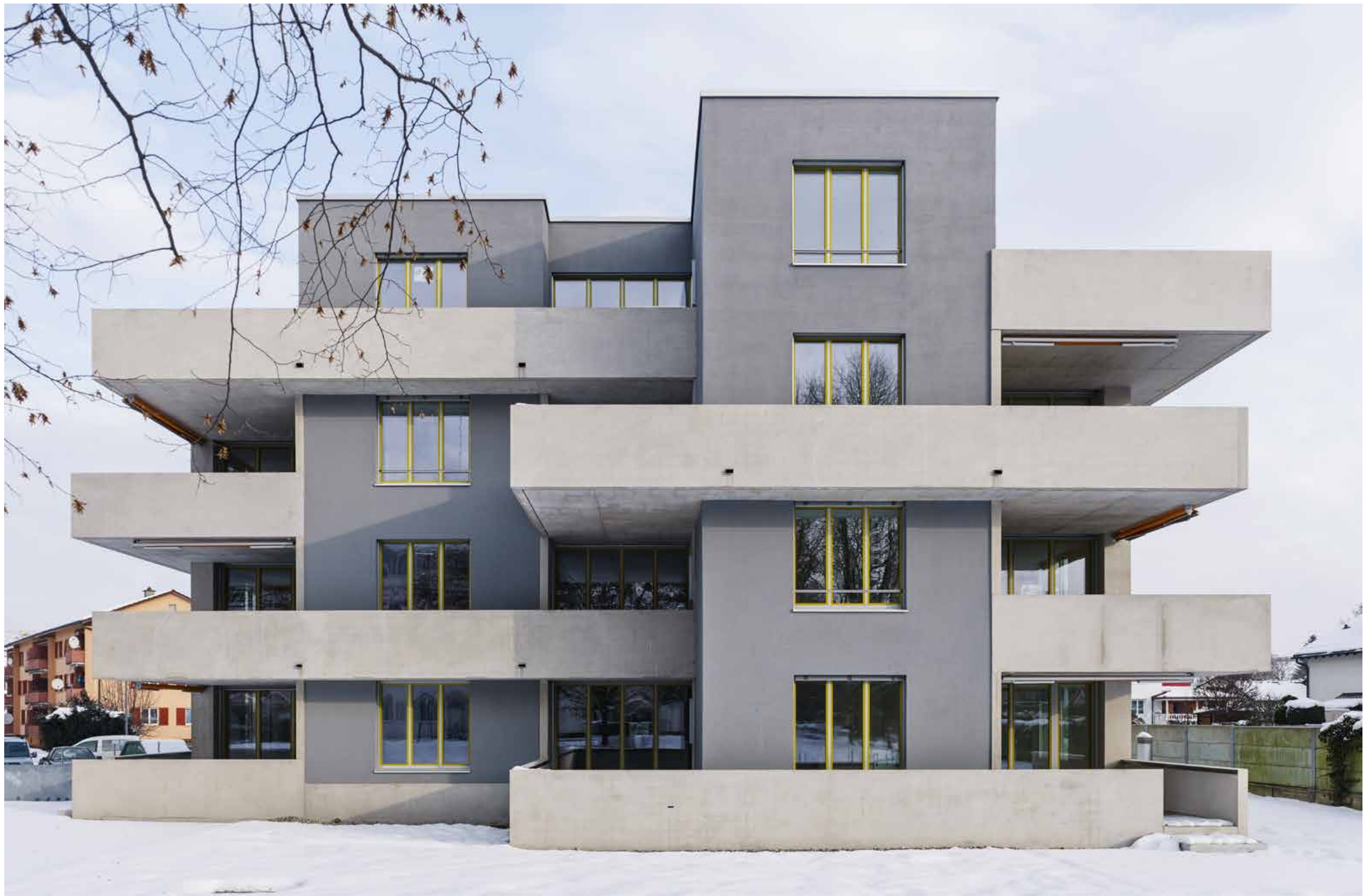
Mehrfamilienhaus Feldstrasse, Urdorf
